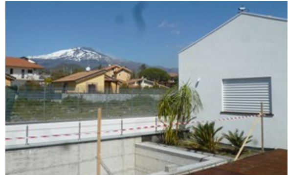
La première maison passive de Sicile. Photo: Passive House Institute
