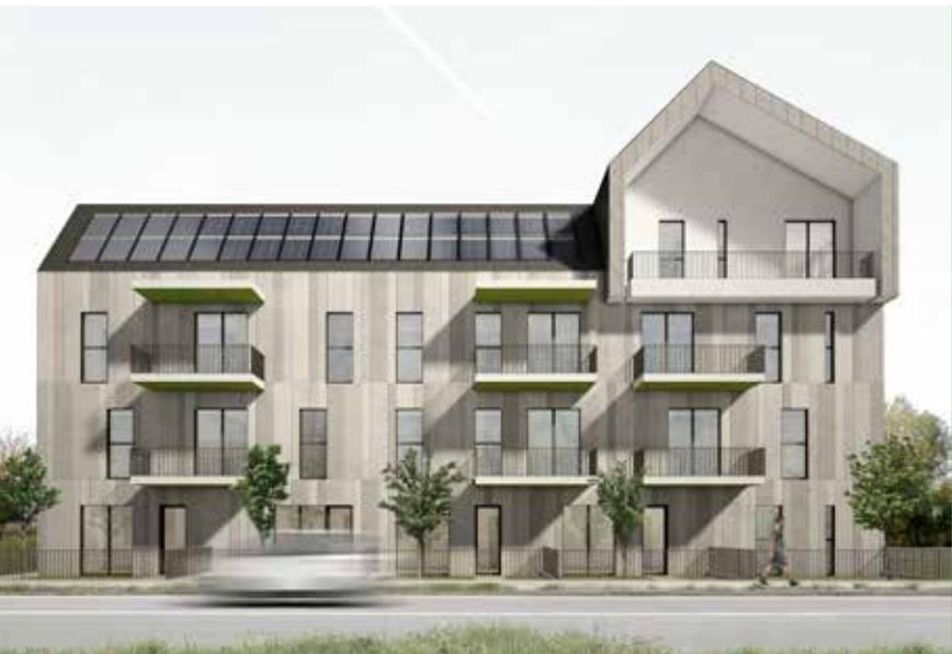
La tipologia a ballatoio massimizza il rapporto superficie/volume, per ridurre le dispersioni termiche. L'edificio sarà isolato termicamente e avrà un'integrazione di rinnovabili: 25 kW di fotovoltaico, 50 m<sup>3</sup> di collettori solari per l'acqua calda. L'edificio è progettato inoltre per raggiungere la certificazione Passive House.
