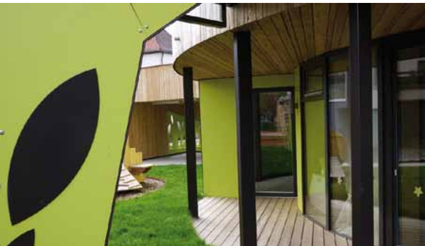
Foto: Kindertagesstätte Traunstein | Zertifiziertes Passivhaus | ArchitekturWerkstatt Vallentin GmbH | Deutschland © Foto Sven Ring
